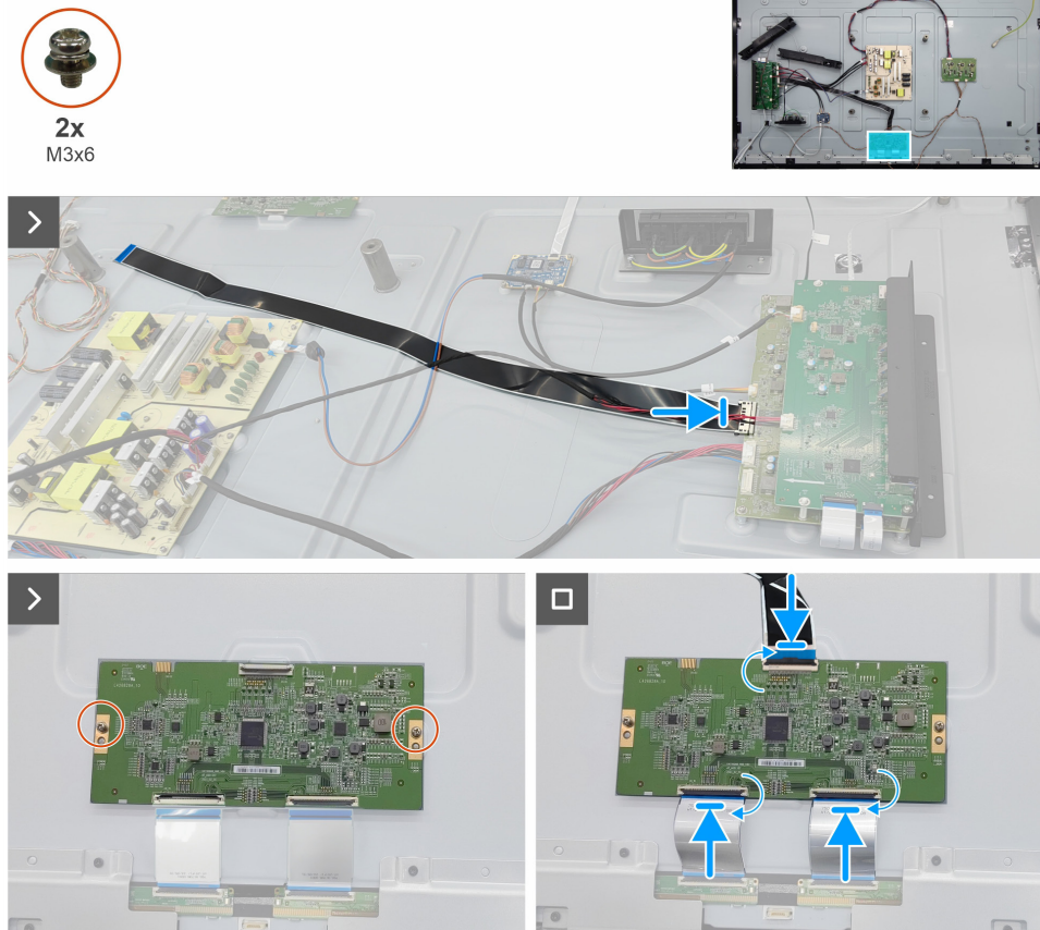
Figura 14. Instalación de la placa T-CON
